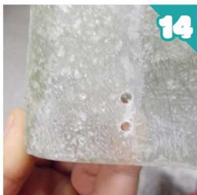
⑭ 留め具を取り付ける穴を開けます。
